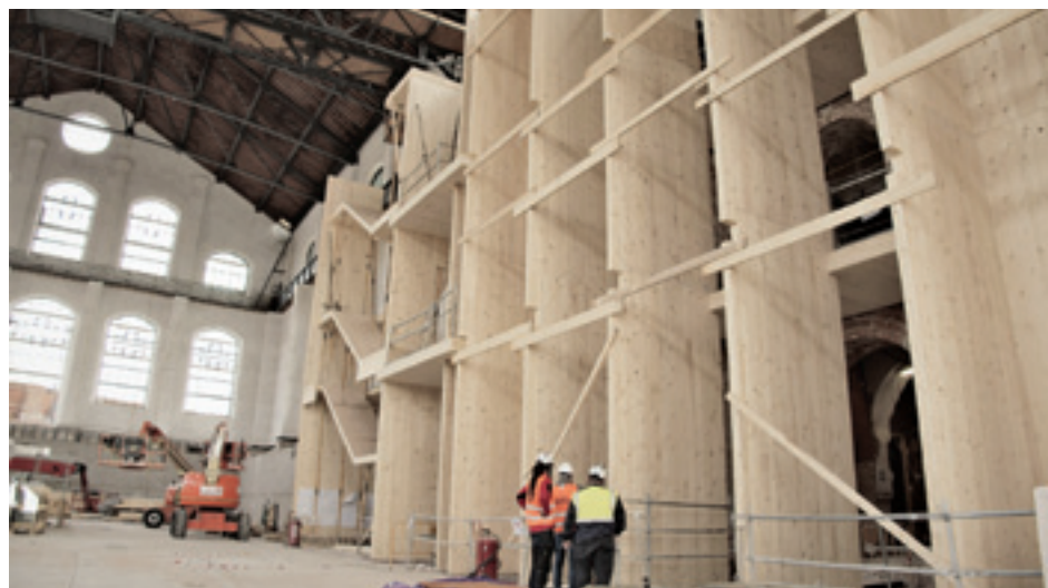
Abgestufte Stockwerke in einer Leichtbaukonstruktion aus Holz. Alle Bilder: Bosch
