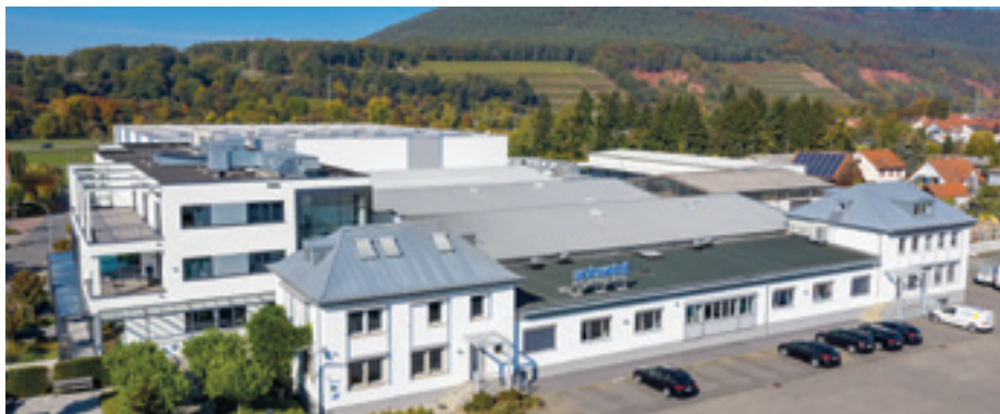
Zentrale in Bürgstadt, Bild: Mainmetall
