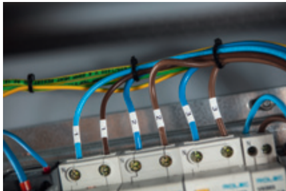
Mit Schrumpfschläuchen ist es sehr einfach möglich, eine flexible und normgerechte Beschriftung zu realisieren.
