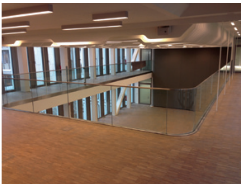
Auch Fußbodenheizung, Estrich sowie Bodenbelags- und Parkettarbeiten im Handelskammer Innovation Campus stammen aus der Hand des Unternehmens aus Ellerbek.
