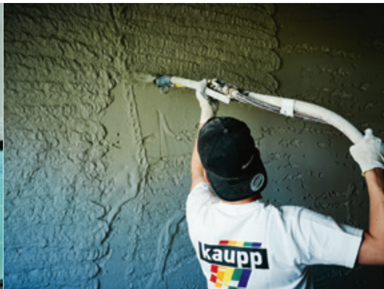
Trockenbauarbeiten, Quelle der Fotos: Kaupp Gmb, Schramberg
