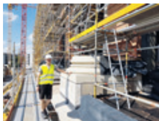
Berliner Schloß Baustelle 3 Südportal Säulenbasen
