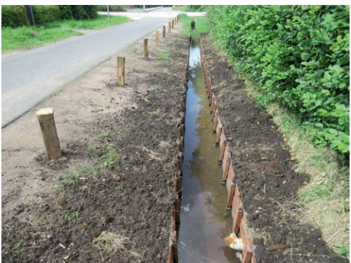
Grabenfußsicherung mit Holzflechtmatten
