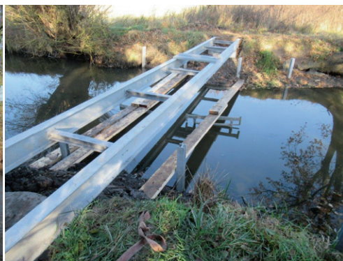
Trägerunterbau einer Fußgängerbrücke
