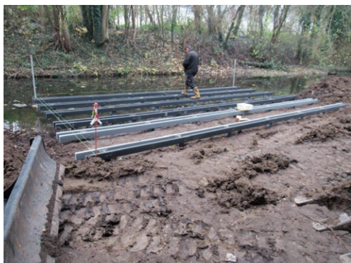
Unterbau des Steges zum Anlegen von Kanuten
