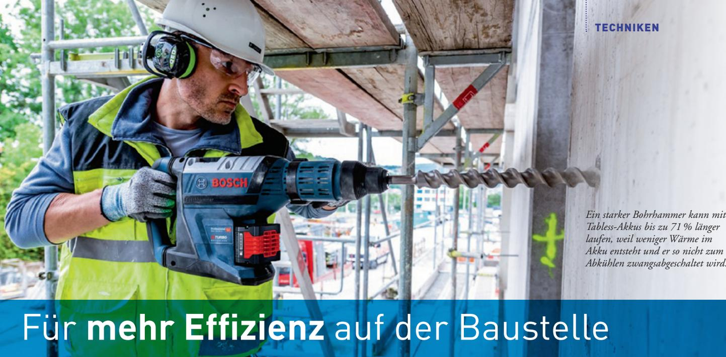
Ein starker Bohrbhammer kann mit Tabless-Akkus bis zu 71 % länger laufen, weil weniger Wärme im Akku entsteht und er so nicht zum Abkühlen zwangsabgeschaltet wird.
