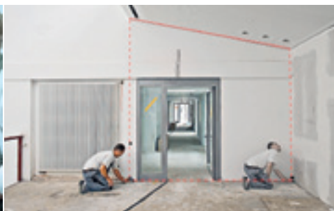
Wenn es um das präzise und schnelle Messen lichter Maße, Flächen oder Höhen geht, sind Laser-Distanzmesser unschlagbar (Bosch)
