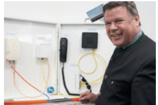
Piet Mayr, 1. Bürgermeister von Zorneding, ließ sich im Servicepunkt-Laden der Deutsche Glasfaser die Anschlusskomponenten erklären. Links ist der Hausübergabepunkt. Über bis zu 20 Meter lange Glasfasern geht es jeweils zum Netzabschlußgerät für die Wohnung (rechts daneben). An dieses wird per Netzkabel ein gängiger Internet-Router oder der Router von Deutsche Glasfaser angeschlossen. Optional kann für den Anschluß am Router eine Set-Top-Box für Internet-TV geordert werden. (Foto: Peter Pernsteiner)
